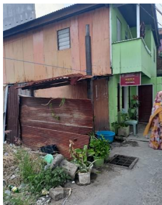
Kondisi Sebelum pemasangan
